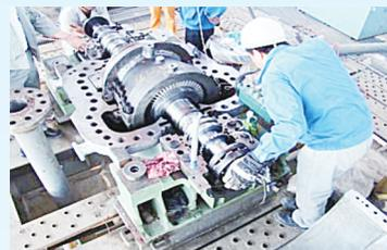
【举例】有的工人站在汽轮机汽缸水平接合面上,戴线手套用手转动转子,时常发生转子将手套挂住而绞伤手指。
