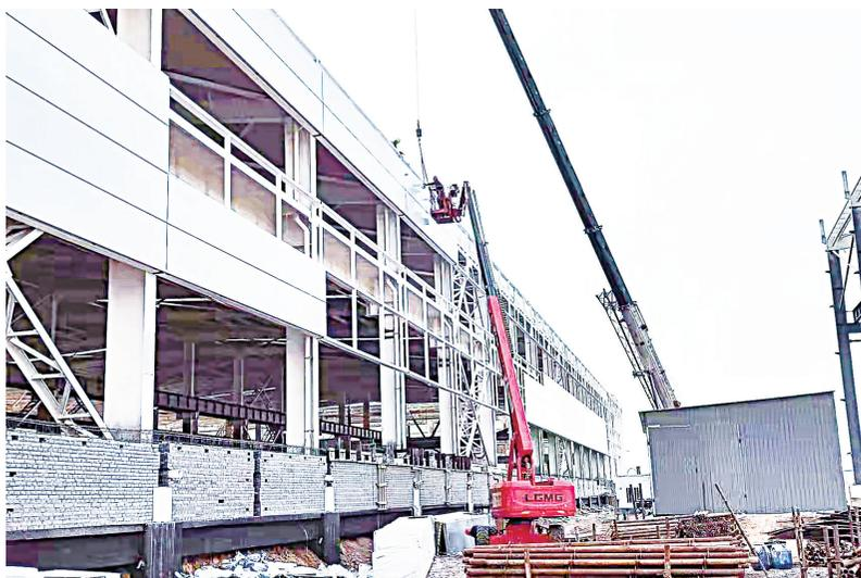
人勤春来早,奋进正当时。3月的大地,气温回升,生机勃勃。在新园区的项目工地现场,机械不停运转,工人加紧施工,抢抓春季施工的黄金季节,全力冲刺各节点目标。图为新园区四标段油膜厂房北墙面板安装作业。
