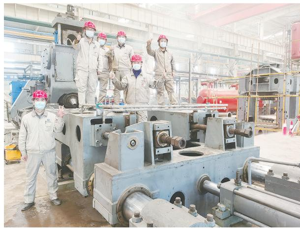
行利旧改造,并对其进行严格的进度监督和质量校验。面对轧机底座数量多、标高不一致、预埋孔洞多、结构复杂等困难和挑战,项目组成员践行“忠诚、担当、执行、成事”的企业作风,对近百个预埋螺栓孔的基础进行精心打磨,又通过对底座逐一调平、找正、预紧、灌浆等环节,最终找平了轧机底座,定准了坐标方向,完成了轧机升级安装的全部任务。
