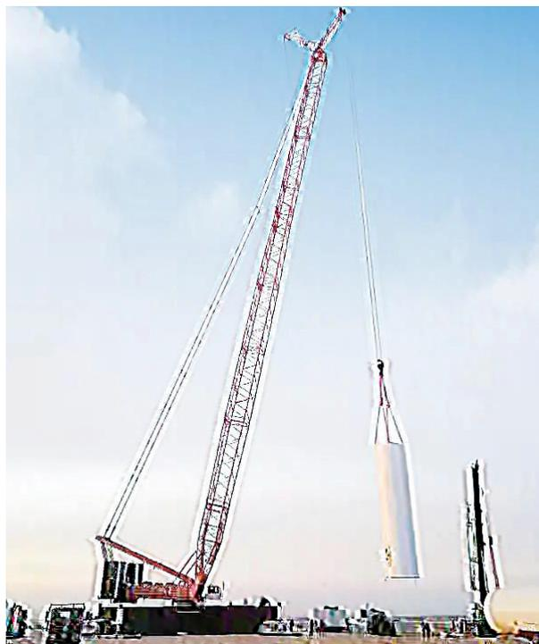
新年伊始,从千里之外的新疆传来一则令人振奋的好消息:2022年1月6日,由太重工程机械分公司制造的国内首台多轴线桁架臂起重机在新疆哈密十三间房五万千瓦风电项目现场成功完成5.0兆瓦风机的首次起吊作业。
